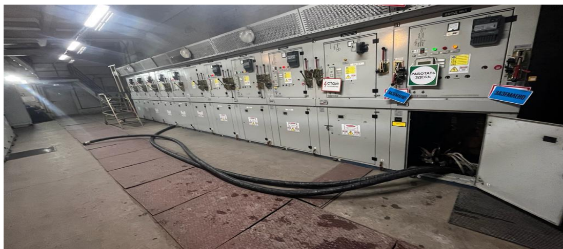
Рисунок 1. Замена силовых кабелей на ТП «ЖДЦ»
